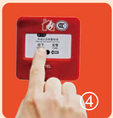
④ 按下箱内消防栓泵启动按钮
