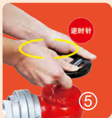
⑤ 打开消防栓上的水阀开关
